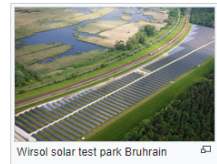
Wirsol solar test park Bruhrain
